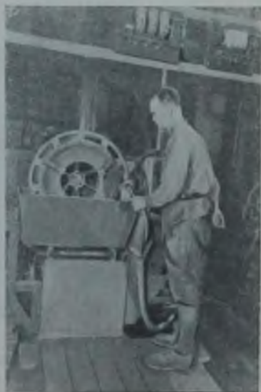
Фиг. 120. Установка для нагрева направляющего колеса.
