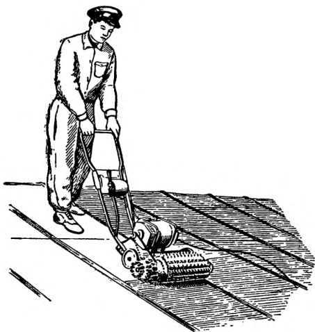
Рис. 131. Очистка поверхности кровли из листовой стали электрощеткой инж. Е. Т. Самодаева
