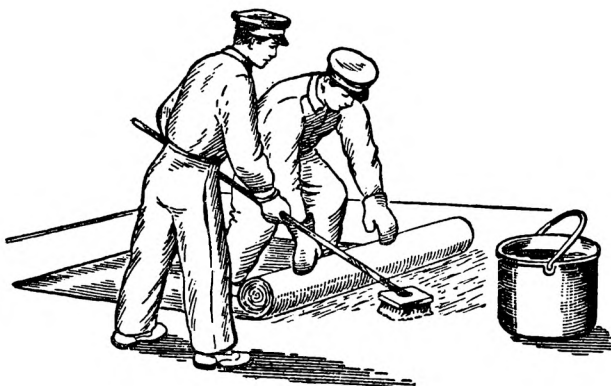
Рис. 195. Ручная раскатка рулонов
