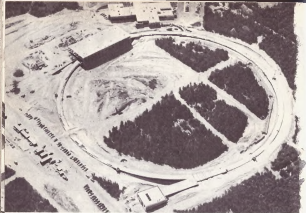
▲ Фиг. 191. Вид с воздуха на строительство Брукхэйвенского протонного синхротрона на 30 Гэв. Магнит длиной в полмили находится в кольцевом подземном туннеле.
