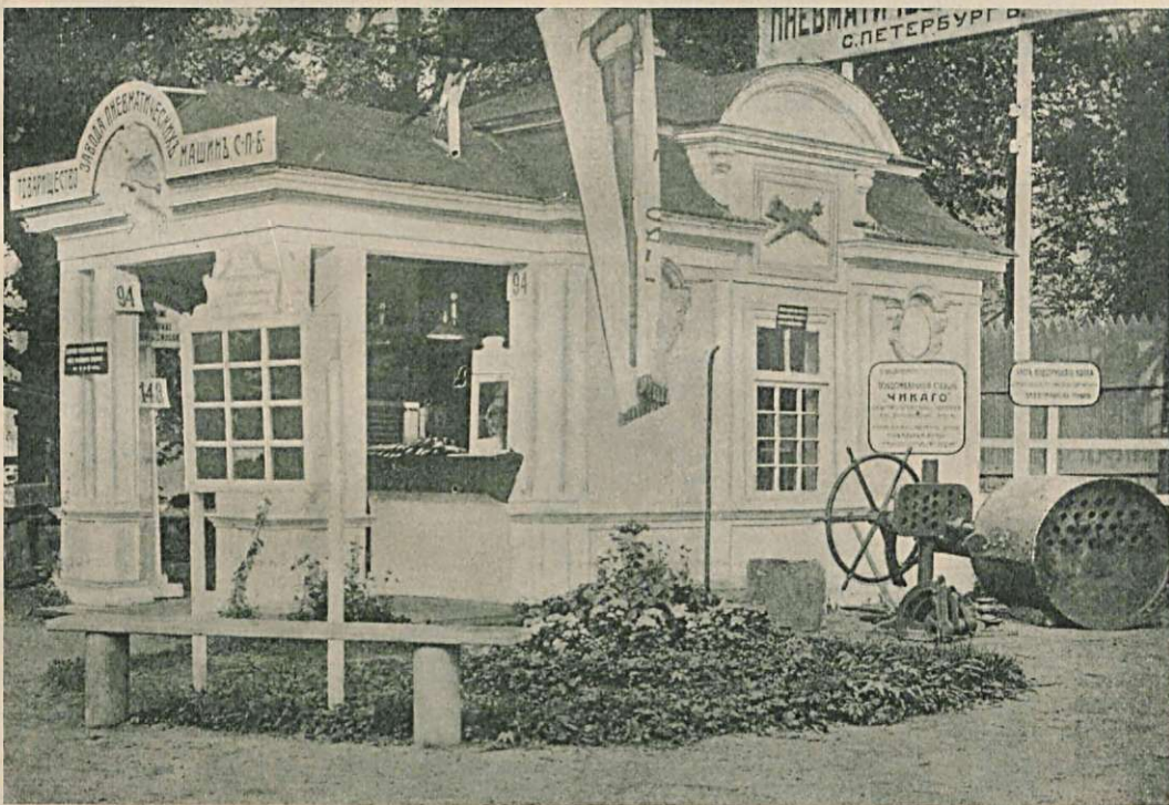
Собственный Павильонъ Т-ва Завода Пневматическихъ машинъ на Выставкѣ (на Каменномъ Островѣ).
