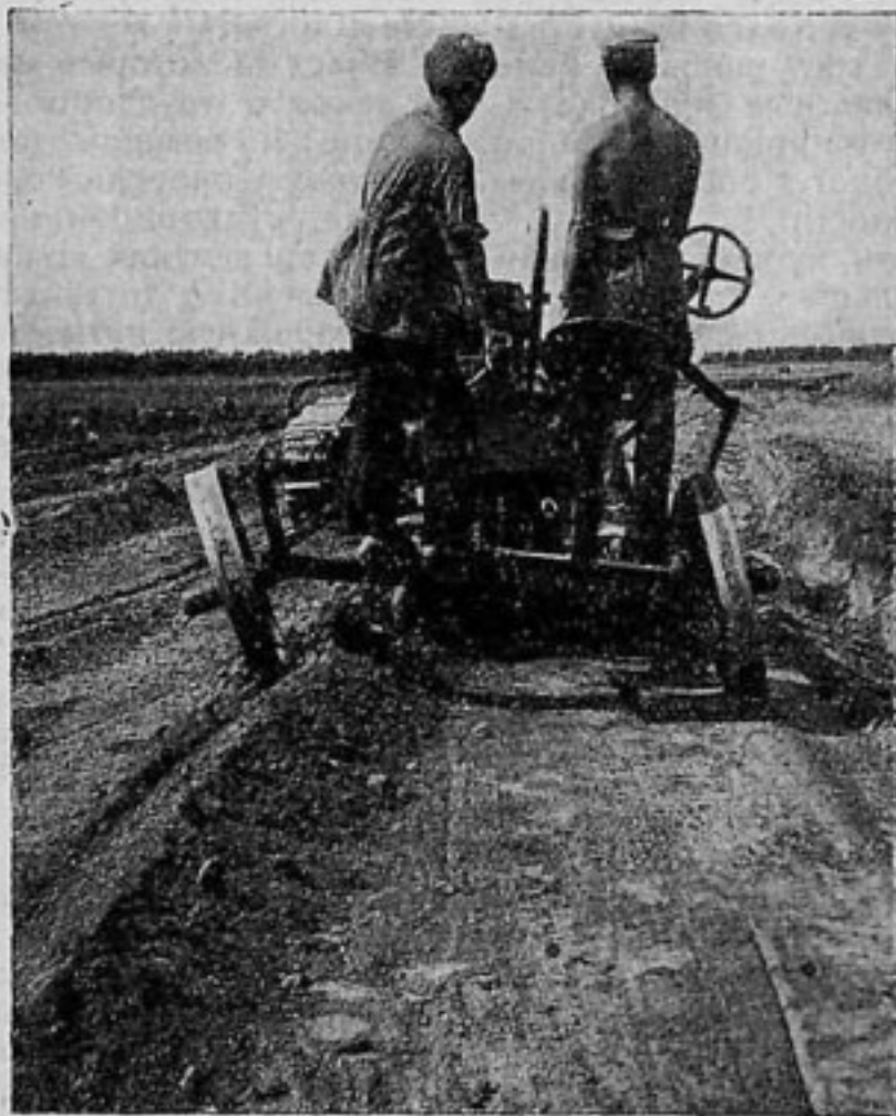
Отвал земли после окончательного углубления кювета
