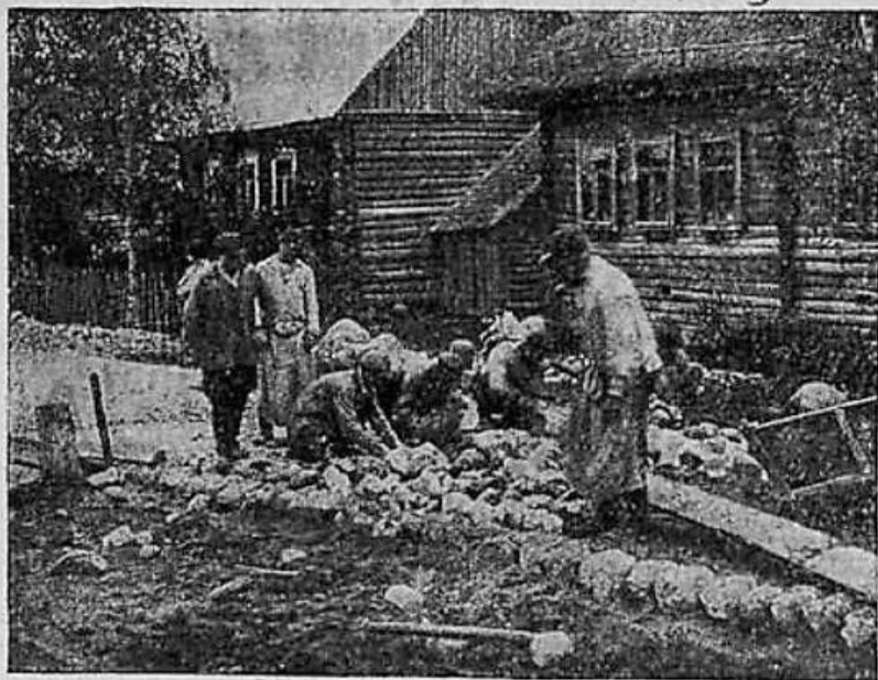
На дорожных работах
