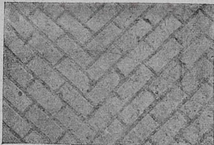
Еид клинкерной дороги со швами заполненными битумом
