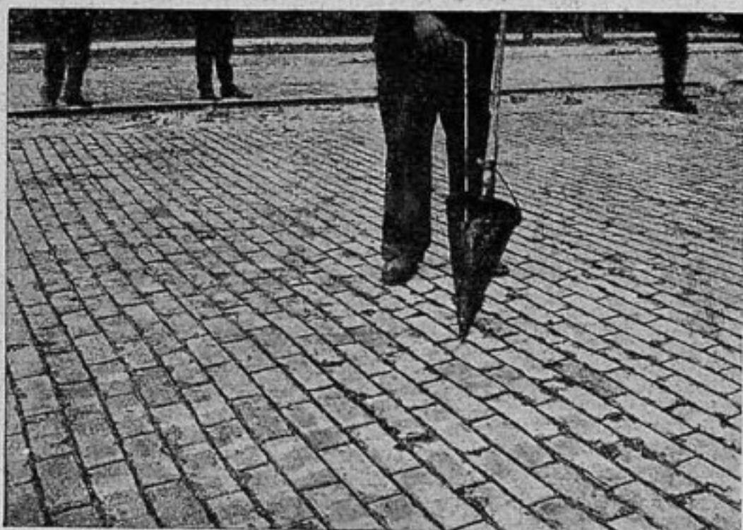
Заливка швов битумом
