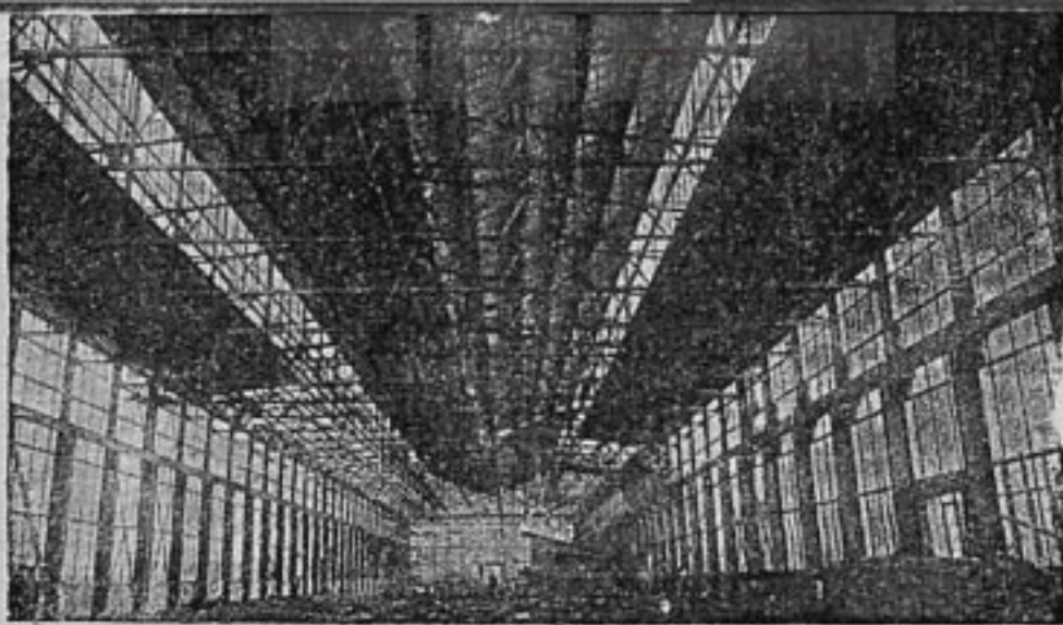
Внутренний вид рессорного цеха автозавода после установки конструкций
