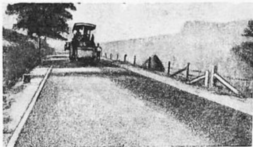
Укатка одежды, устроенной из холодного асфальта
