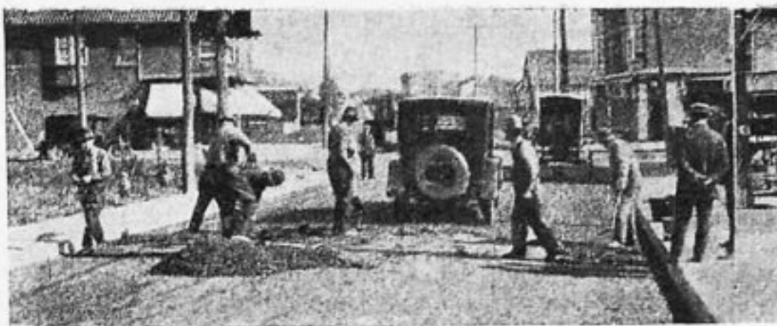
Работы по устройству дороги из эмизита
