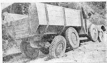
Шестиколеска-вездеход Австро-Даймлер с качающимися полусьями и трубой вместо рамы (типа Татра)
