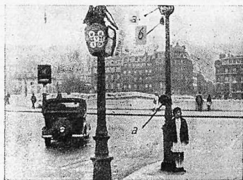
Рис. 2. Светофор находится на краю панели на углу улицы: а—фонарь светофора, б—электрзвонок (звонит, когда загорается фонарь)
