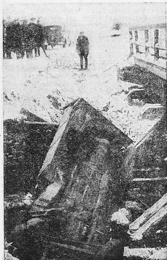
Автомобиль, свалившийся с моста при резком торможении на скользком месте
