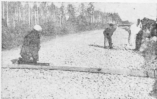
Профилировка и россыпь щебня при постройке гидротирированной дороги на 3-м участке шоссе Москва—Горький
