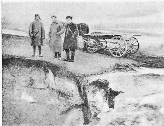
Дорога между Кисловодском и Пятигорском после каждого дождя размывается и обваливается. Этот участок дороги наносит немало убытков местному хозяйству
