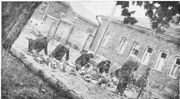
На дорожных работах
