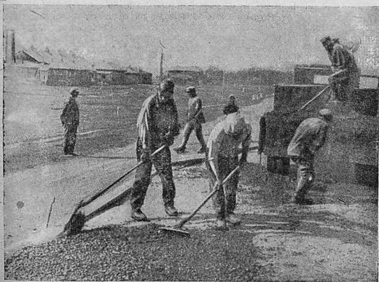
Работа по укладке асфальта на Ленинградском шоссе (Москва)
