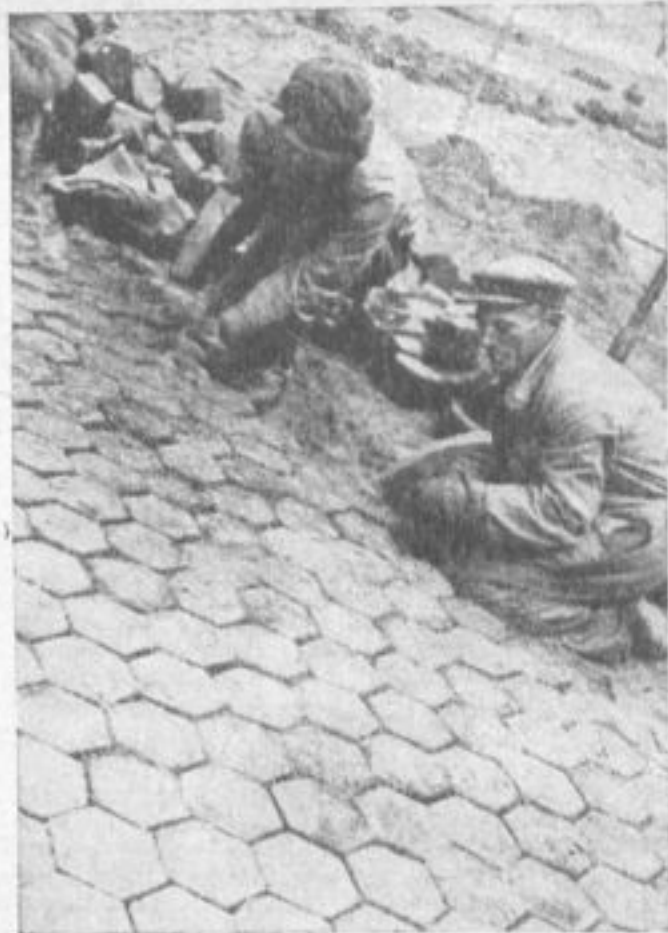
Прокладка торцовой дороги (Ивановская промышленная область)
