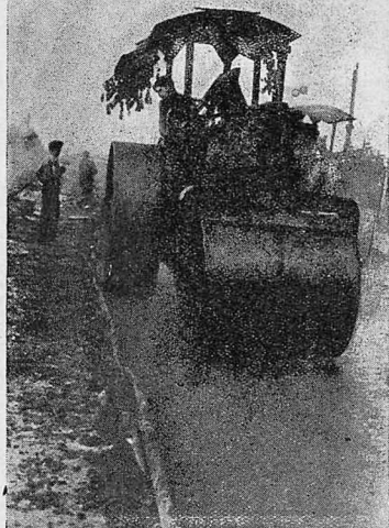
Строительство московского Паука. На снимке — укатка Ленинградского шоссе
