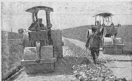
Работа по постройке Шемахинского шоссе (Азербайджан)
