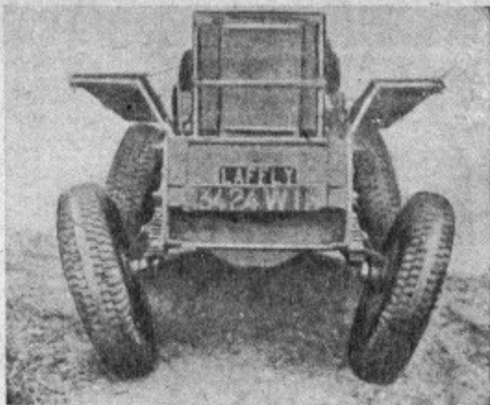
Рис. 7. Каждое колесо автомобиля Ляффли, независимо от других, свободно приспособляется к неровностям грунта
