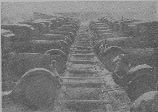
Рис. 1. Общий вид площадки, оборудованной для обогрева автомобильных двигателей паром
