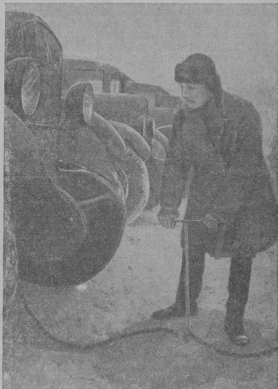
Рис. 3. Пуск пара для подогрева двигателя
