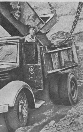
Н. Грудинин на стройке Ангарской ГЭС.
